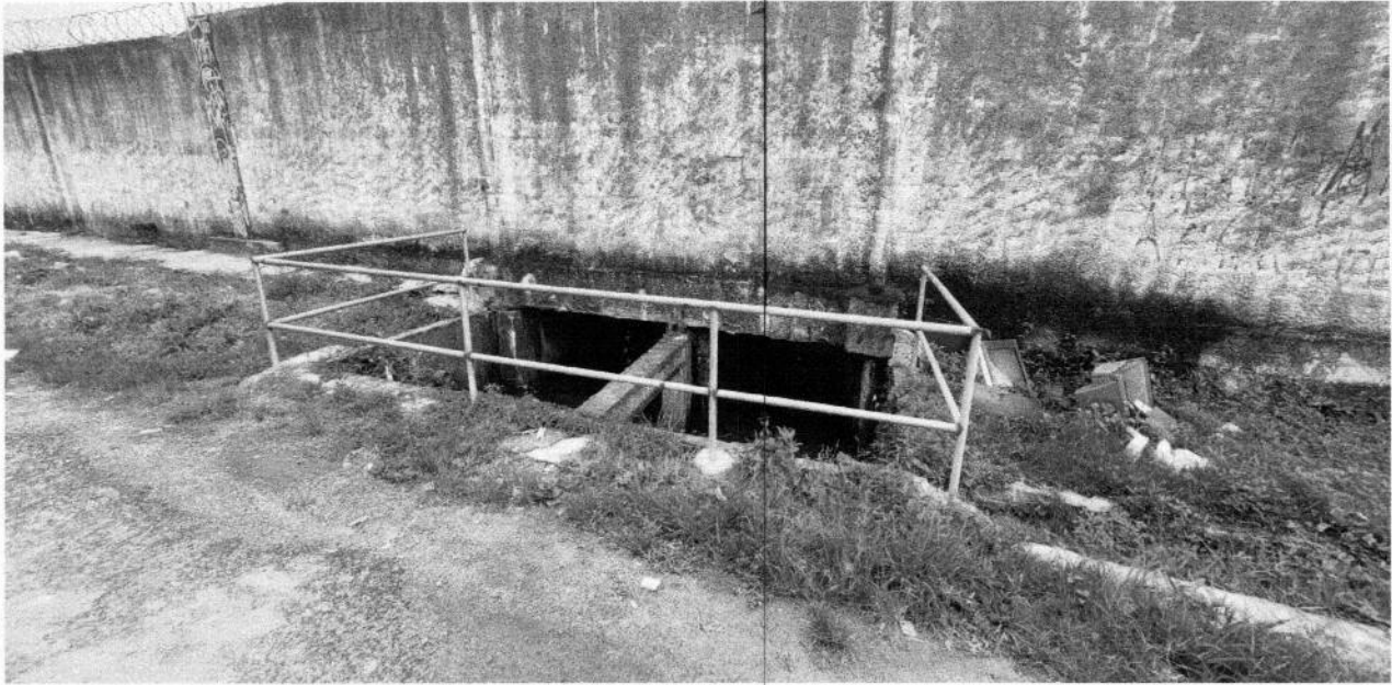
INSTALAÇÃO DE GRADIL DE PROTEÇÃO NA RUA PROJETADA, EM FRENTE AO N° 62, VILA ESTAÇÃO – MOGI DAS CRUZES.
